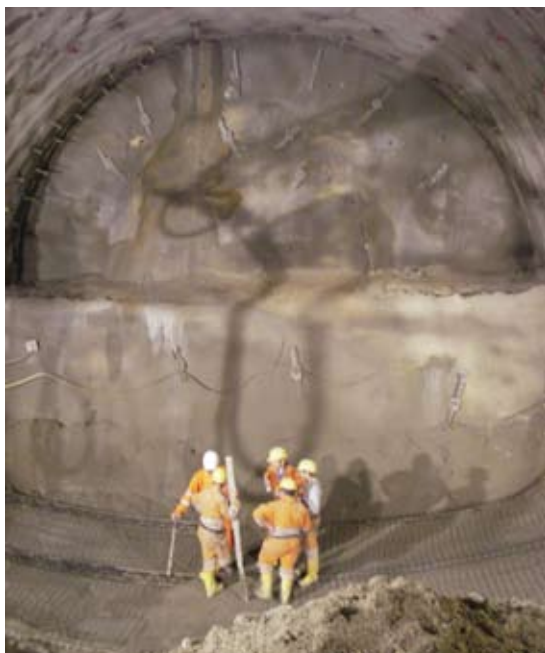
Bild 12 Massive Ortsbrustsicherung bei Herstellung des kurzen Ringschlusses.
