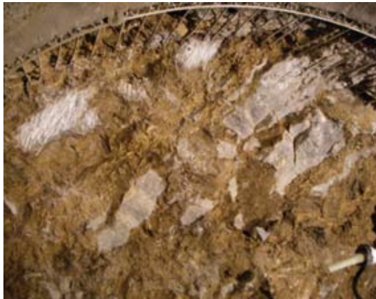
Bild 14 Trümmerkarbonate im Westvortrieb (2).
