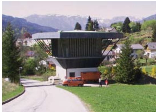
Bild 3 Lüftungsbauwerk im „Steingraben“ mit unterirdisch angeordneter Betriebszentrale.
