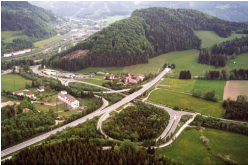
Bild 2 Luftbild der Anschlussstelle „Mürzzuschlag West“ mit dem Westportal. Im Hintergrund das Stadtgebiet von Mürzzuschlag.
