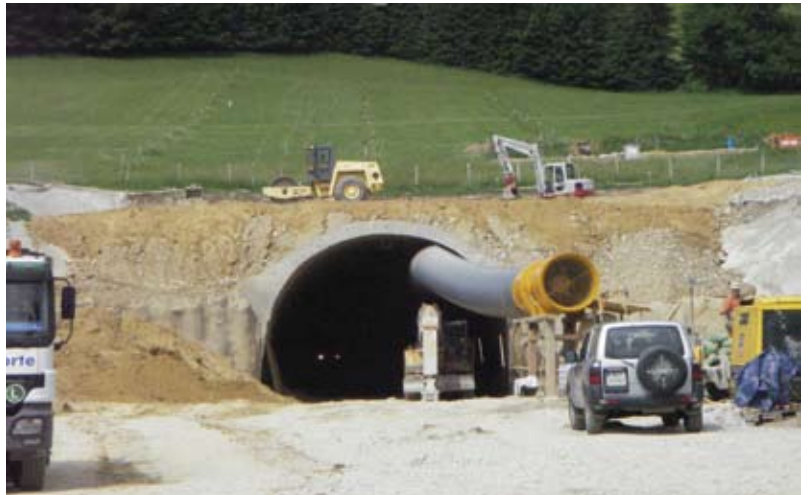
Bild 9 Deckelbauweise West.
